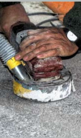
Händisches Nacharbeiten mit kleinem Rotoschleifer
